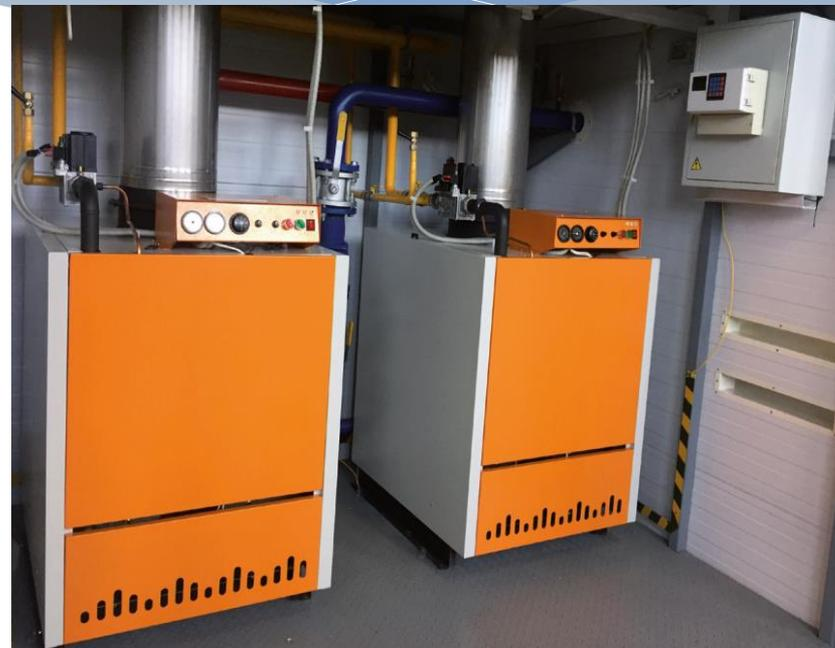
Остальные котлы укомплектованы инжекционной горелкой атмосферного типа, блоком газовых клапанов и автоматикой безопасности фирмы «Honeywel» (США).
